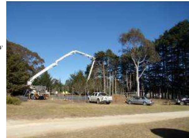
Pouring the new court
